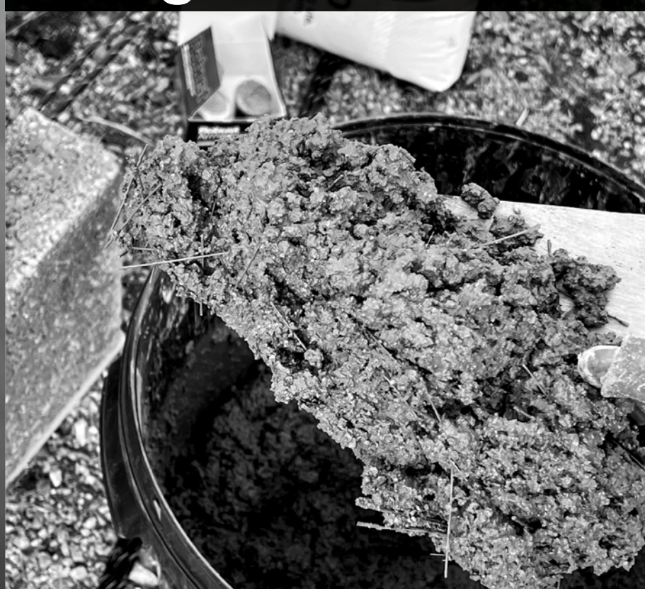
Ferdig armert mørtel
