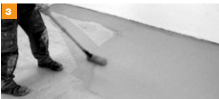
1. Strøk påføres med eller uten sklisikring
