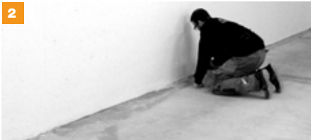
Masker alle områder som ikke skal påføres epoxy
