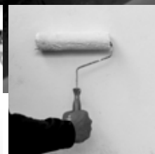
Gulv og vegg
